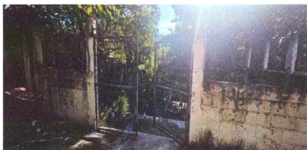
Foto 5: Sustitución de portón de metal
