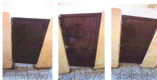
Foto 6: Mantenimiento a estructura (lijado, cambio de tubo , cepillado, sujeciones, aplicación de pintura) a puertas servicios sanitarios
