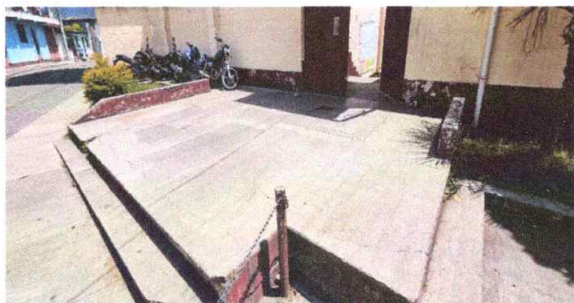
Foto 3: Reparación de planchas de concreto de patio
