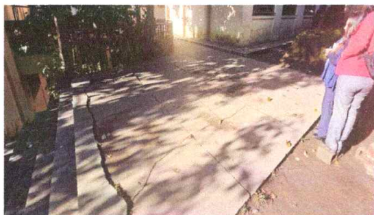
Foto1: Reparación de planchas de concreto de patio
