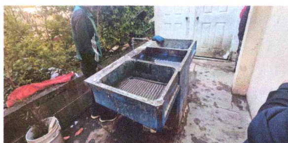
Foto 4: Sustitución de pila de cemento de dos lavadero
