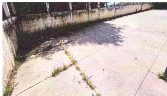
Foto 2: Reparación de planchas de concreto de patio
